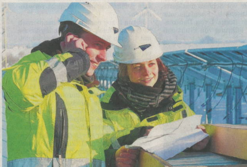
Bad Lausick setzt auf erneuerbare Energie: Die Fotovoltaik-Anlage ist fertiggestellt, zwei Windkraftanlagen (hinten) gingen Ende 2009 in Betrieb.
